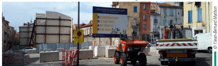
Îlot Puig démolit en décembre 2021. Malgré les promesses de Louis Aliot, depuis, aucune concertation et rien de reconstruit.
