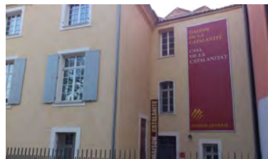
Maison de la Catalanité
