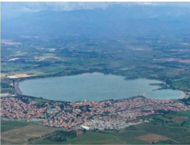
Vue sur les 17 millions de m 3 d'eau du lac de Villeneuve-de-la-Raho.
